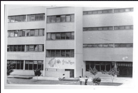
24. Edificio B construido con aportes de la Alianza para el Progreso entre 1966 y 1968.
