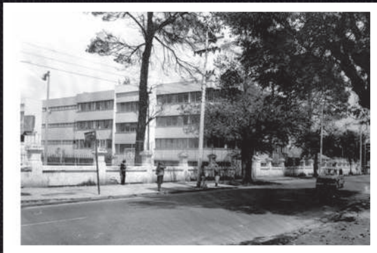
19. Vista del edificio B, ubicado en la carrera 11 en la década de 1960.
