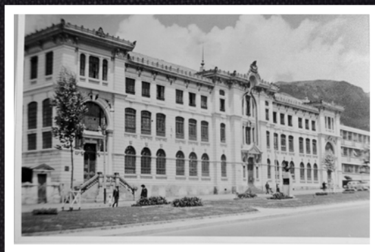
5. Edificio construido en 1927 y demolido en 1969 a causa de temblor de gran magnitud.
